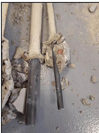
Fotografía nº12: «Barras de acero tras romper hormigón»
