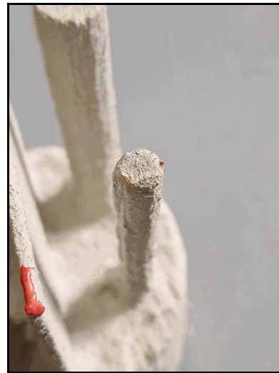
Fotografía nº6: «Puntos de corrosión en barra de acero al finalizar el ciclo de SO 2 »
